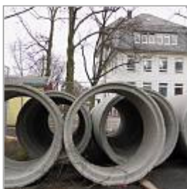
Baustelle Bildungslandschaft: Wie das pädagogische Konzept stockt derzeit auch die Sanierung der Gebäude an der Schulstraße. (Bild: Ramme)
